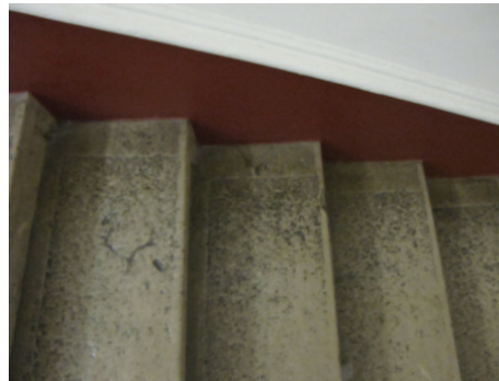
03-7.2.1.6 Kamnite stopnice v prostoru P20, P20a (31,41 m 2 )
