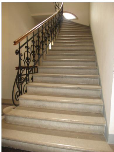
03-7.2.1.4 Kamnite stopnice v prostoru P15a (77,70 m 2 )
